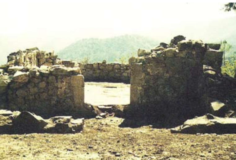
Φωτογραφία της κατεστραμμένης εκκλησίας της Μονής της Παναγίας των Ηλιακών, πριν από την προστασία της με στέγαστρο
